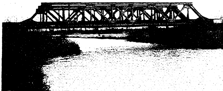
Wolvega (Weststellingwerf). Spoorbrug over de Linde bij Wolvega.
