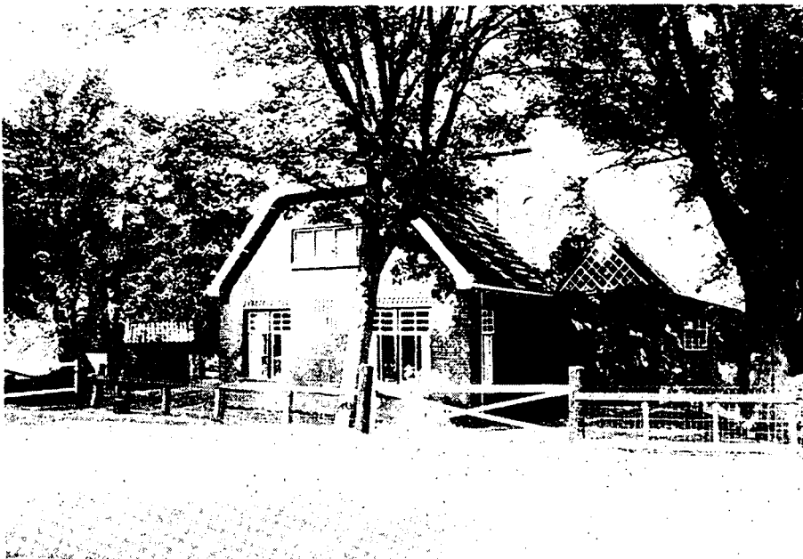
Lemmer (Lemsterland). Kleine boerderij, verwant aan het timpe-type, met karakteristieke detaillering voor de bouwtijd, ca. 1925. Kenmerkend voor de streek is het bovenlicht boven de inrijdeur van de schuur.
