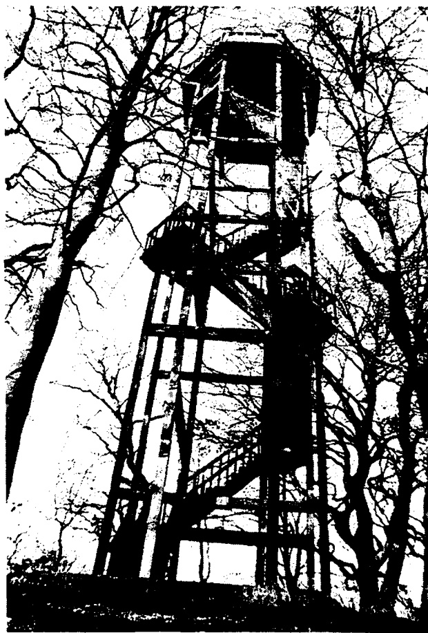
Oranjewoud (Heerenveen). De betonnen constructie van de Belvédère in het Bos van Tjaarda, werd in 1924 als toeristische attractie gebouwd door en naar ontwerp van de fa. Boltje & Buwalda uit Heerenveen.
