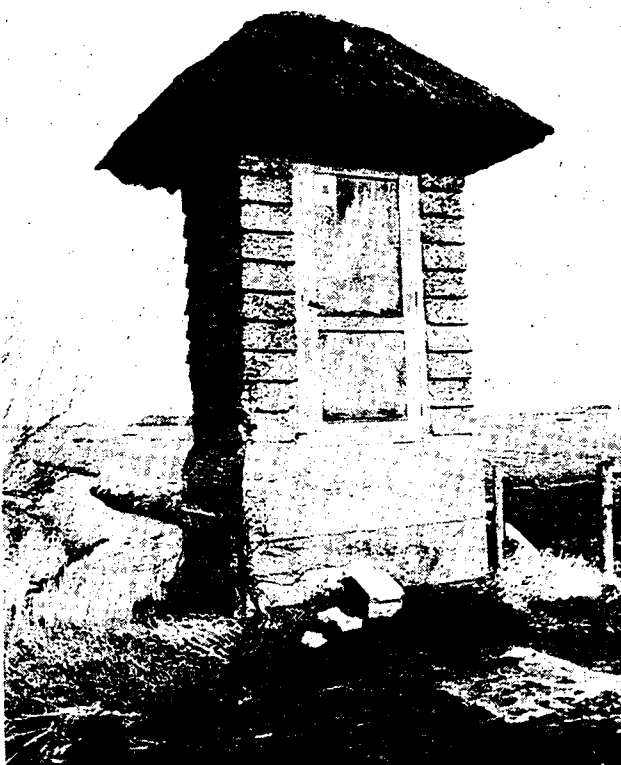
Tytsjerk (Tytsjerksteradiel). Het gemaaltje aan het voormalige Louwsmeer uit de dertiger jaren is in beton uitgevoerd maar suggereert een rustieke bouwtrant door pseudo-potdekseling en een rieten kapje.
