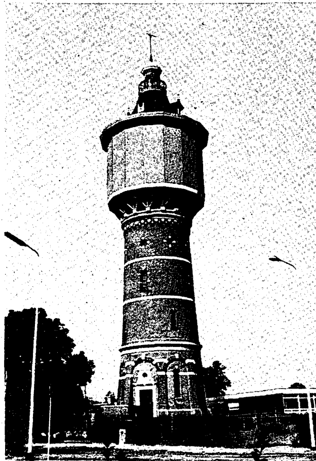
Sneek. De watertoren van Sneek, in 1909 gebouwd naar ontwerp van Gerrit Halbertsma (1855-1928), was de tweede watertoren in Friesland. Het reservoir is in 1962 ommetseld.
