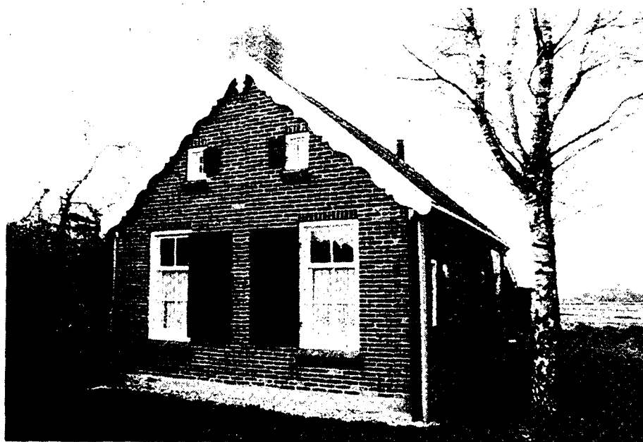
Munnekeburen (Weststellingwerf). Veenarbeiderswoning aan het Tsjongerpap, waarschijnlijk uit het derde kwart van de vorige eeuw. De precieze ouderdom van dergelijke woninkjes, die in grote getalen in de veengebieden werden gebouwd, is doorgaans moeilijk te bepalen.
